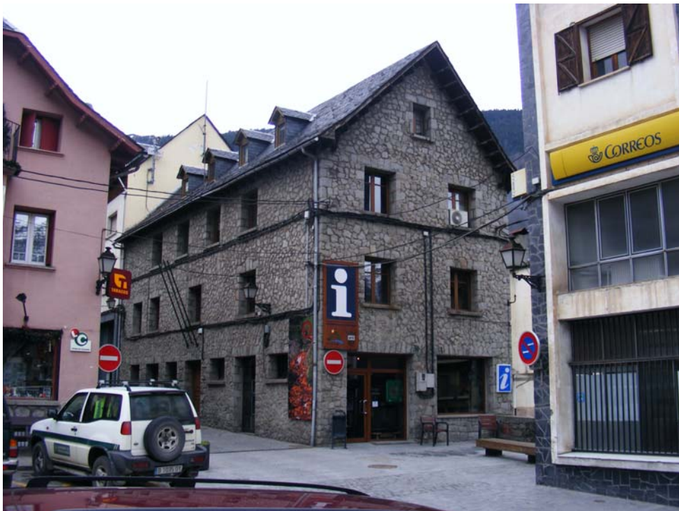
1. Edificio objeto de la reforma.
