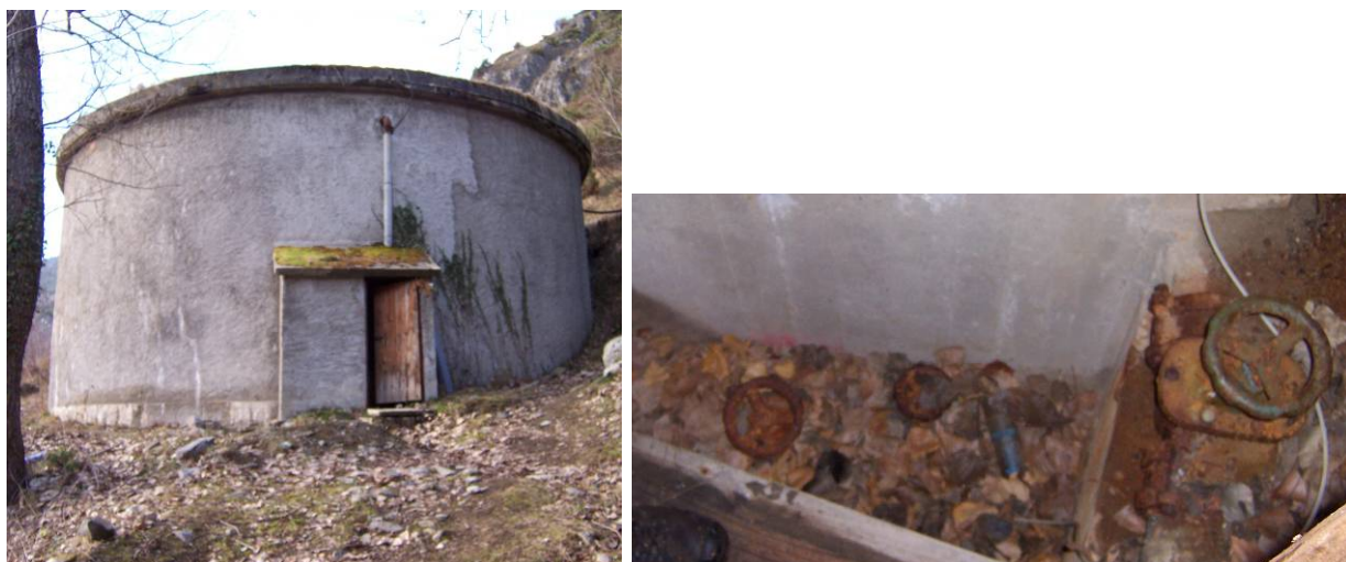
Fig. 1 Estat actual del dipòsit i detall de la valvuleria.
